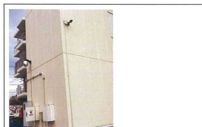
広島市・賃貸マンション、駐車場監視
