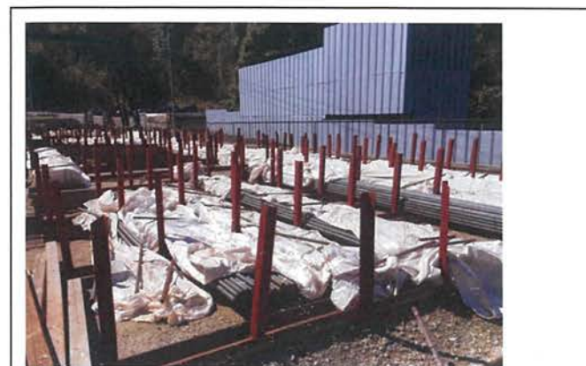
広島市・鉄筋工事業、加工場監視
